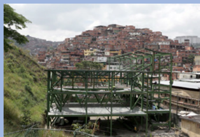
Rohbau Fitnesscenter Chacaos, Chile
